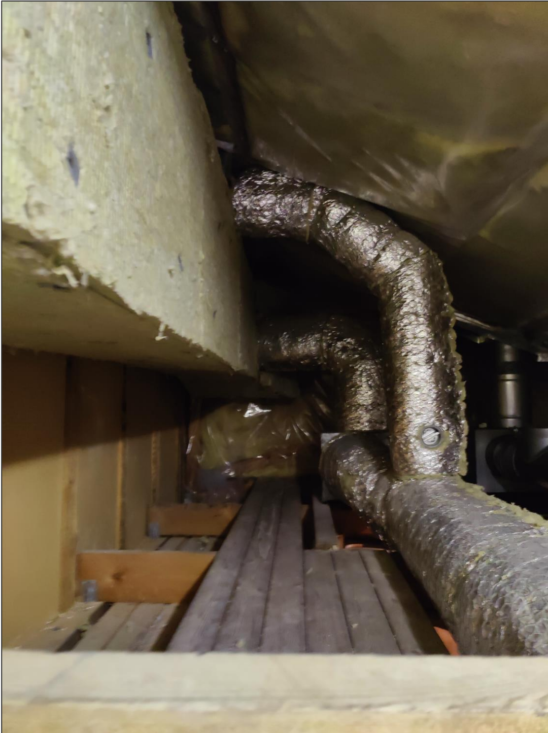
Figur 2.6: Lofttrummet i aktivitetscentret fremstår fuldstændig forseglet uden indflyvningsmuligheder for flagermus.
