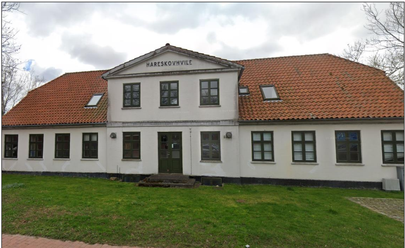
Figur 2.5: Hareskovhvile. Bygningen fremstår ude fra med forskellige indflyvningsmuligheder for flagermus omkring på konstruktionen. Der var dog ikke adgang til hulrummet i skunken eller under taget udefra.
