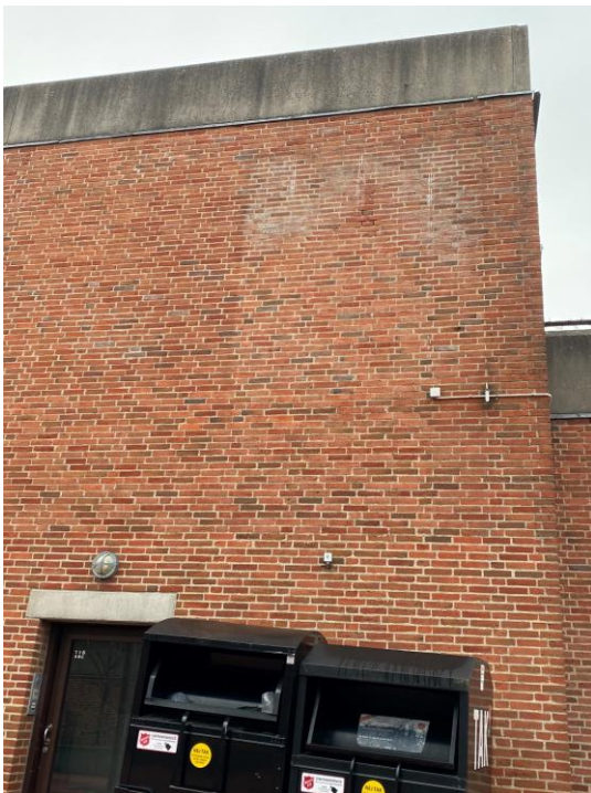
Foto 7A. TF2 : Tagkonstruktionen. Udluftningshullerne er på denne side af bygningen, men kan ikke ses tydeligt på foto.
