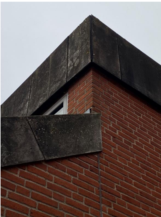
Foto 11A. Byggefelt 13, 14, 15 og 16: Muligvis eternitplader.
