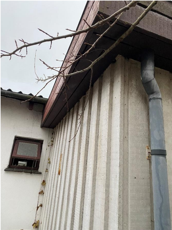
Foto 1A. Byggefelt nr. 39. Forladt parcelhus.
