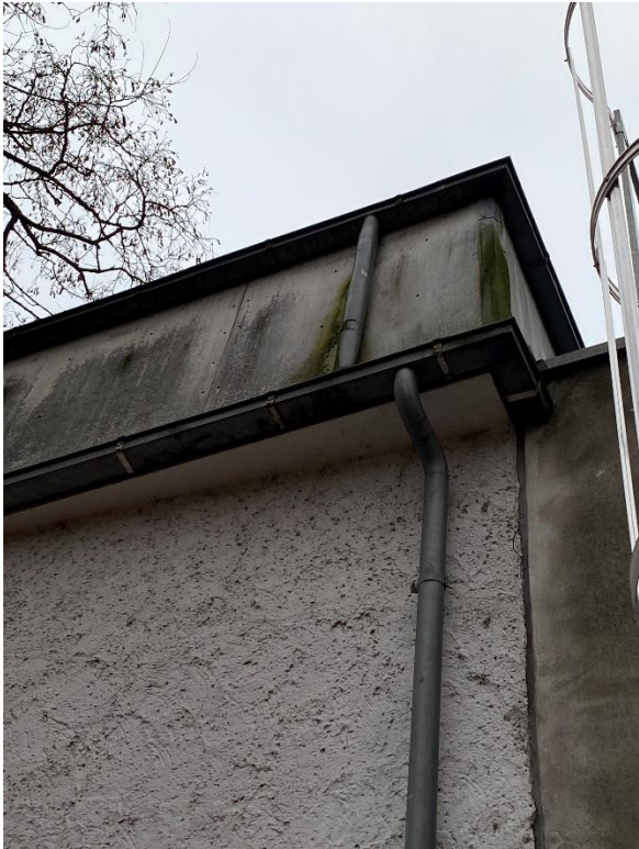
Foto 4A. Byggefelt 6: Tagkonstruktion på den østlige del af bygningen.
