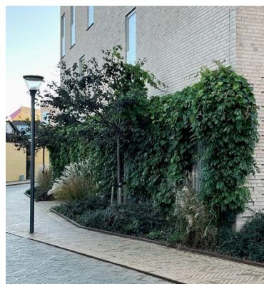
Eksempel på grøn facade samt grøn kantzone.
