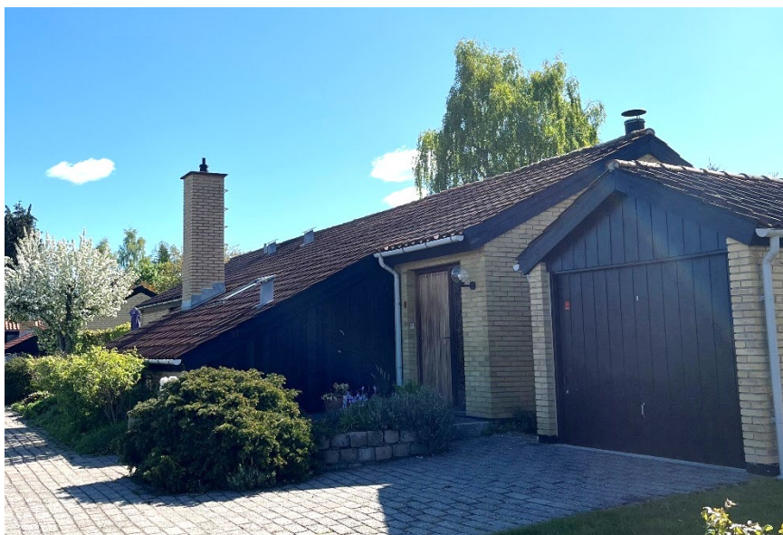
Billedet viser den karakteristiske sidebygning, samt taghældning på beboelsesbygningen og garagen.
