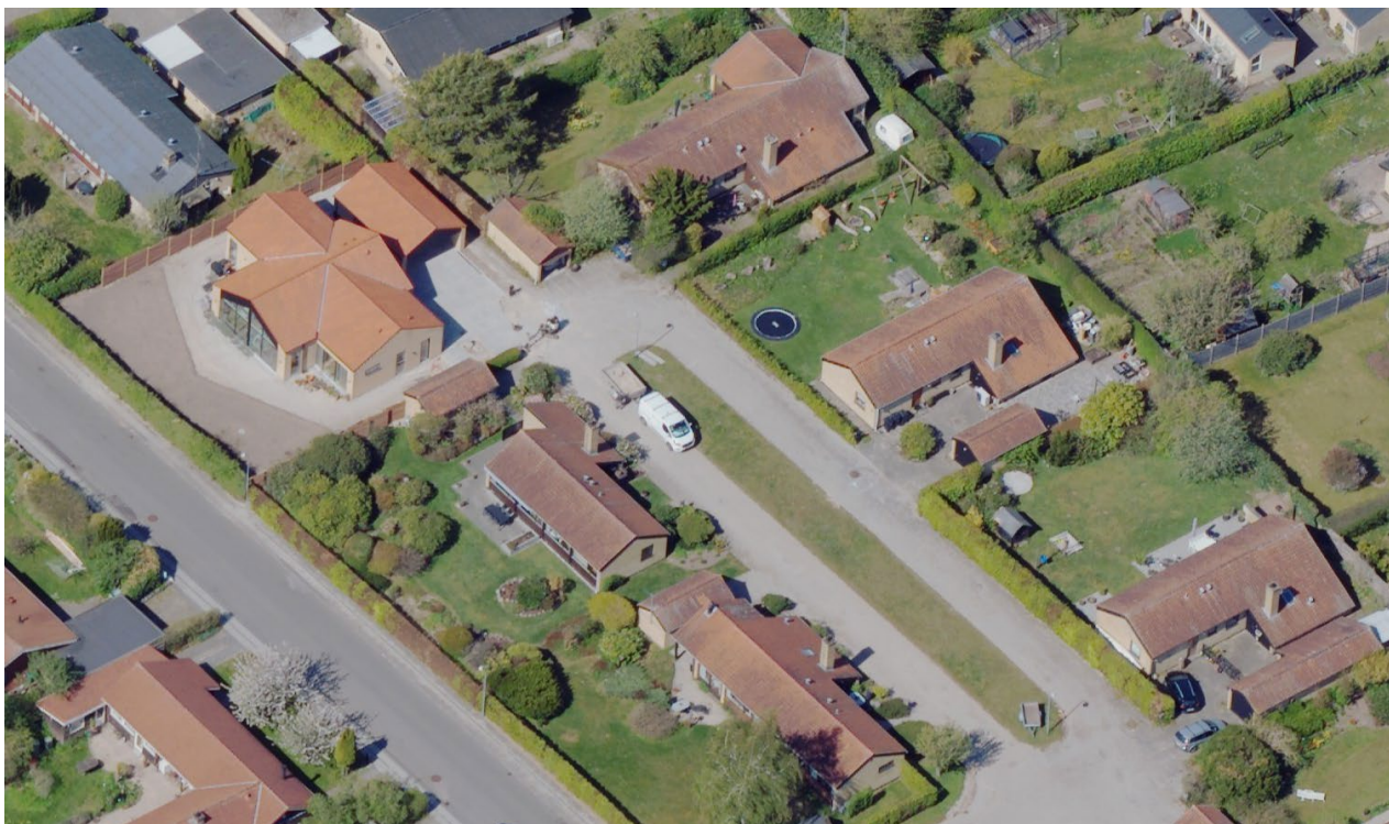
Billedet viser hvordan et nybygget korshus, i øvre venstre hjørne, bryder med områdets øvrige struktur og længdeprofiler.
