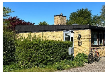
Foto af tagkonstruktion med lodretstillet træbeklædning i sort.
