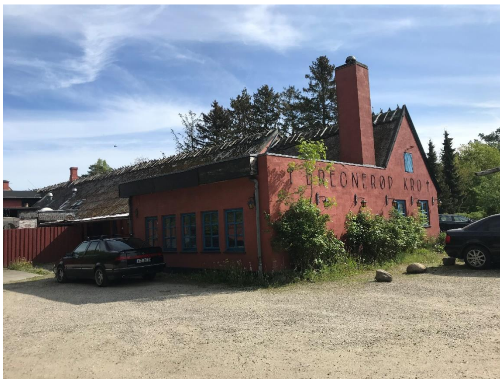
Foto maj 2022. Nyere tilbygning i krobygningens sydligste ende.
