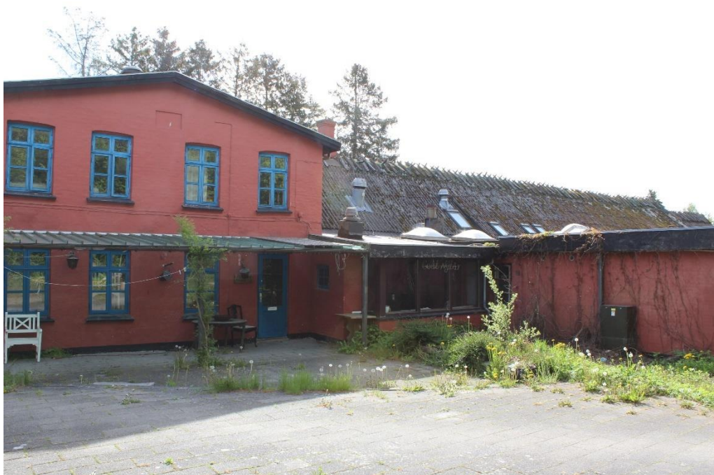
Foto maj 2022. Bagsiden af den nordligste del af ejendommen og nogle af de mange tilbygninger
