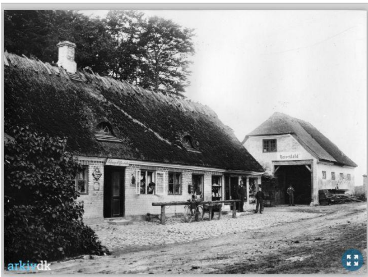
Foto: Furesø Museer / Arkiv.dk Den nordligste del af Bregnerød Kro fotograferet mellem 1900-1909, hvor rejsestalden kan ses i sit tidligere udtryk bagerst i billedet. Krobygningen og rejsestalden er endnu ikke bygget sammen og facaden på krobygningen står i blank mur med tydelige fuger og vandrette murstik over vinduerne.
