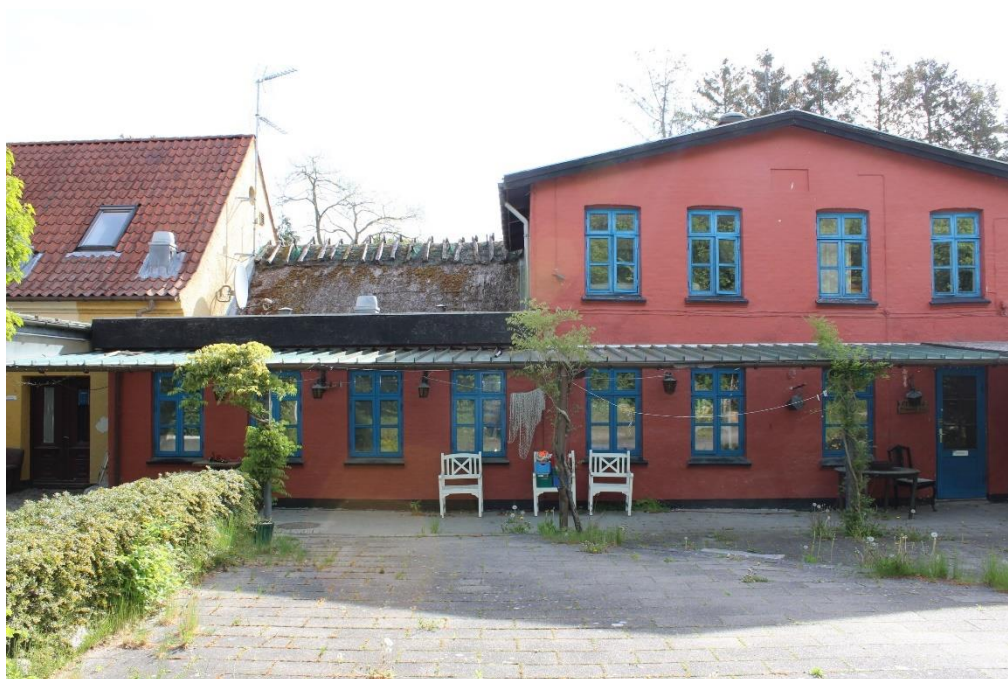
Foto maj 2022. Sammenbygning mellem den tidligere rejsestald og krobygningen set fra bagsiden.
