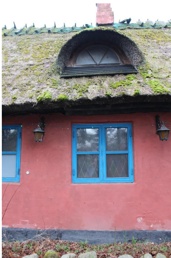
Foto maj 2022 Der er enkelte tagkviste og en bevaret skorsten
