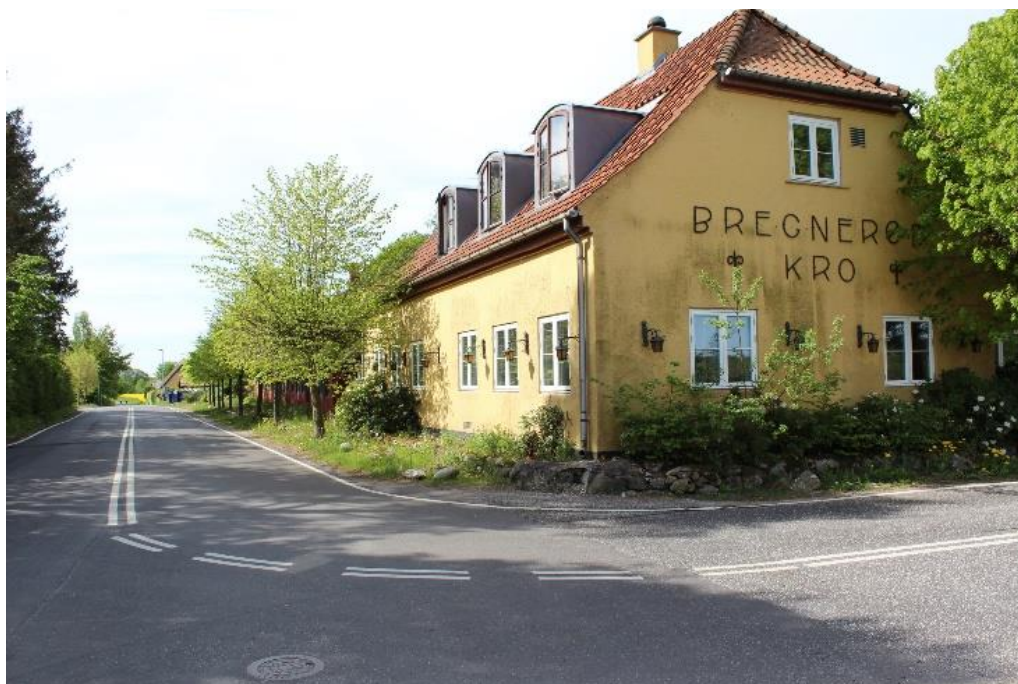
Bregnerød Byvej 2a set fra nord i krydset mellem Bregnerød Byvej og Høveltevangsvej. Maj 2022 Den gule bygning udgør den tidligere kros nordlige del og indeholder rester af rejsestalden, der blev ombygget og udvidet til beboelse i 1987
