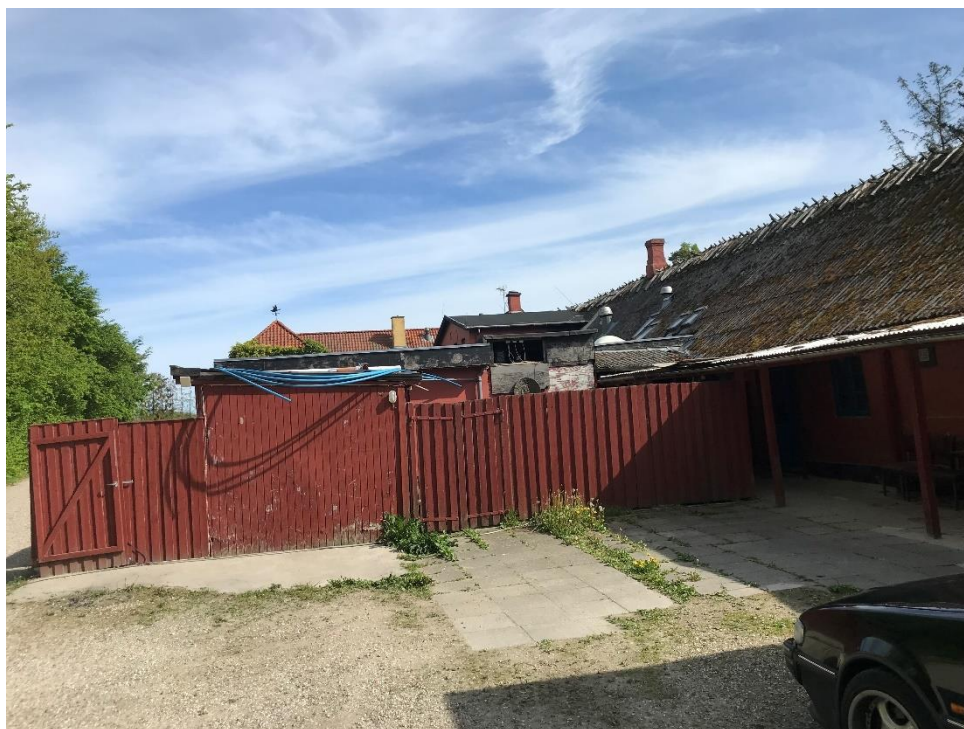
Foto maj 2022. Bagsiden af ejendommen består af en lang række forskelligartede knopskydninger og den oprindelige kro kan knapt nok erkendes. Tagfladerne på den ældste del af ejendommen er udskiftet til bølgeeternit med kragetræer fra facadesidens stråtag.
