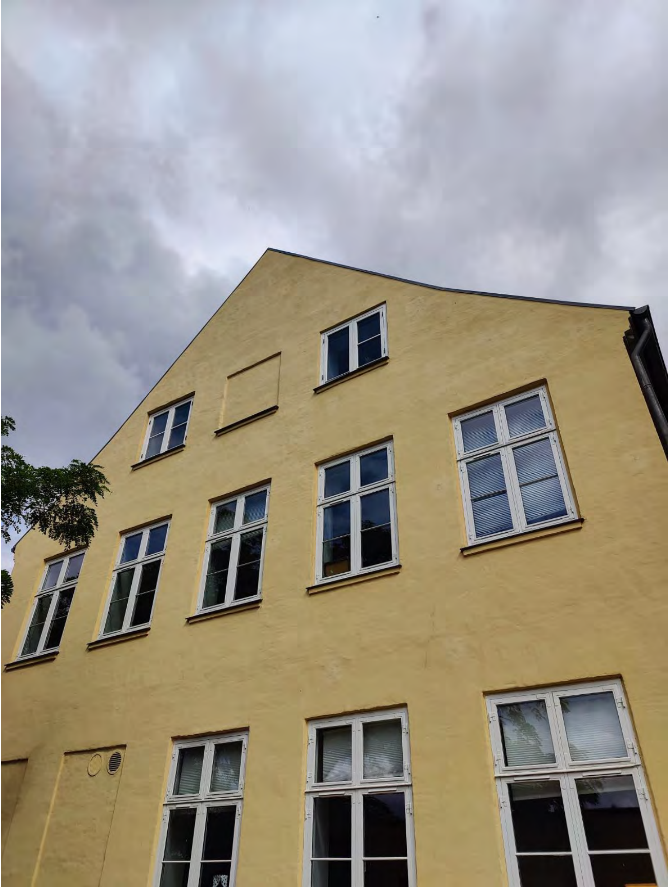
Figur 4.5: Endegavl udefra på bygning 1.
