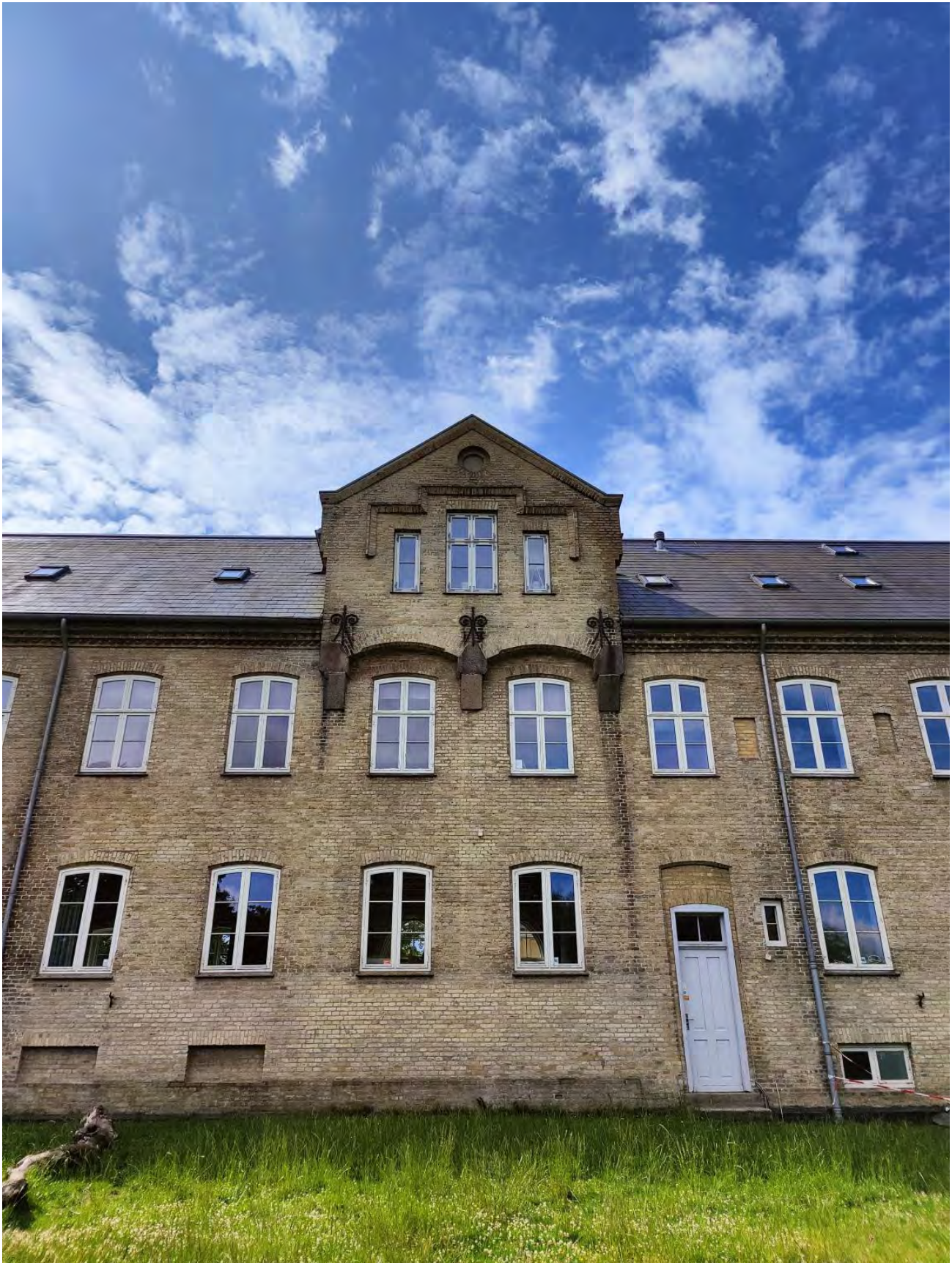
Figur 4.2: Endegavlen på bygning 3, hvor flagermus tidligere har kunnet flyve ind.
